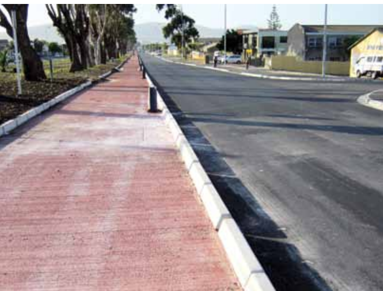
Bus lane in Tableview Road (Melkbos IRT).
